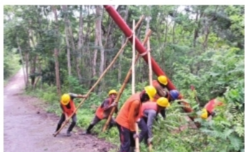
TIANG LISTRIK - Kekompakan dan kerja sama tim sangat di butuhkan untuk proses pendirian tiang listrik yang dilakukan oleh para petugas mitra kerja pelaksana pembangunan jaringan listrik desa.
