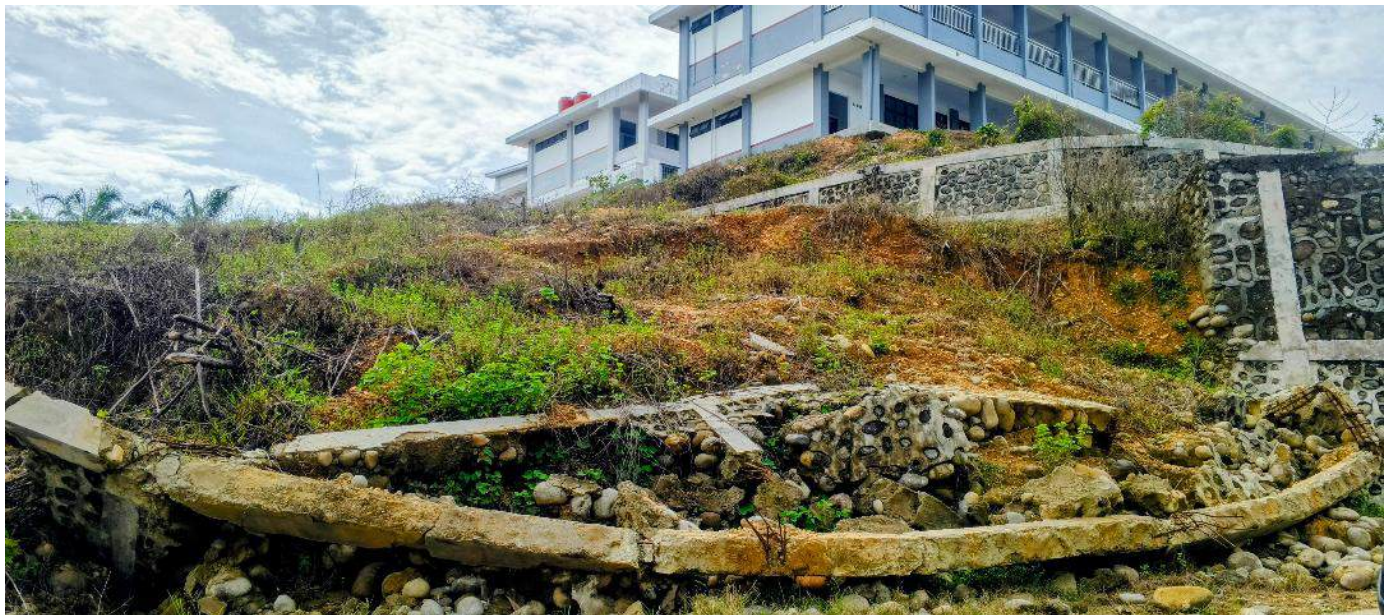
RETAINING wall gedung SMAN-2 Besitang di yang berlokasi di Kelurahan Kampung Lama ambruk.
