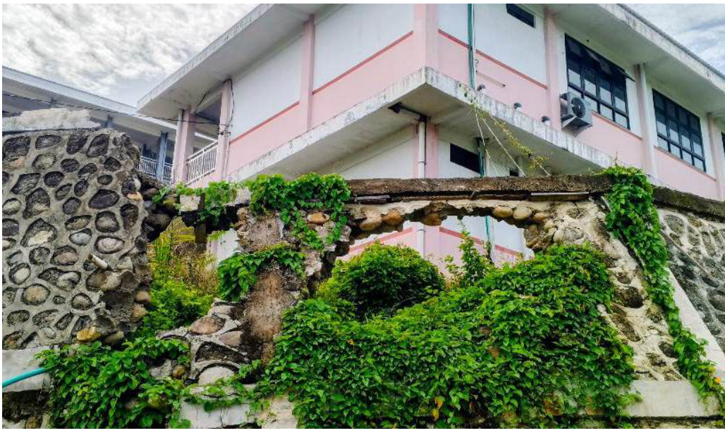
BANGUNAN gedung SMAN-2 Besitang yang berada di atas perbukitan terancam ambruknya retaining wall.
